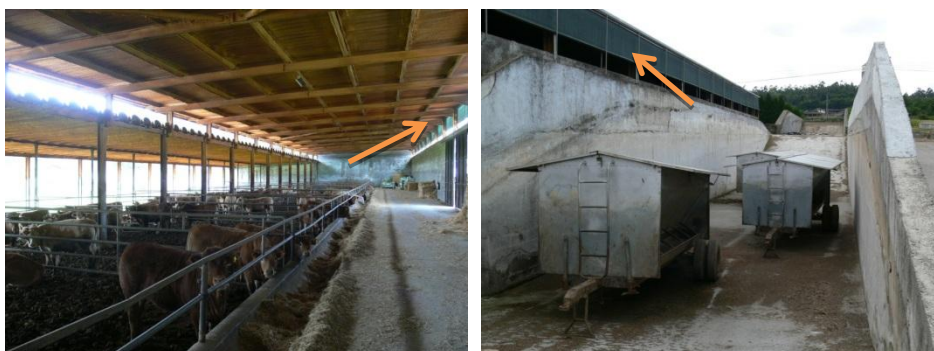
Fotografia 2.5 e 2.6 – Redes mosquiteiras reguláveis em altura presentes nos Edifícios B e C; neste dia apenas parte das aberturas superiores estavam totalmente desimpedidas
